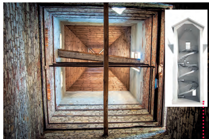
Wieża suszarni chmielu przygotowana do montażu krętych schodów
