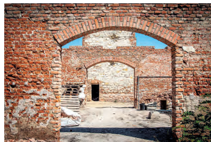
Mury ruin wzmocniono nowymi elementami konstrukcyjnymi
